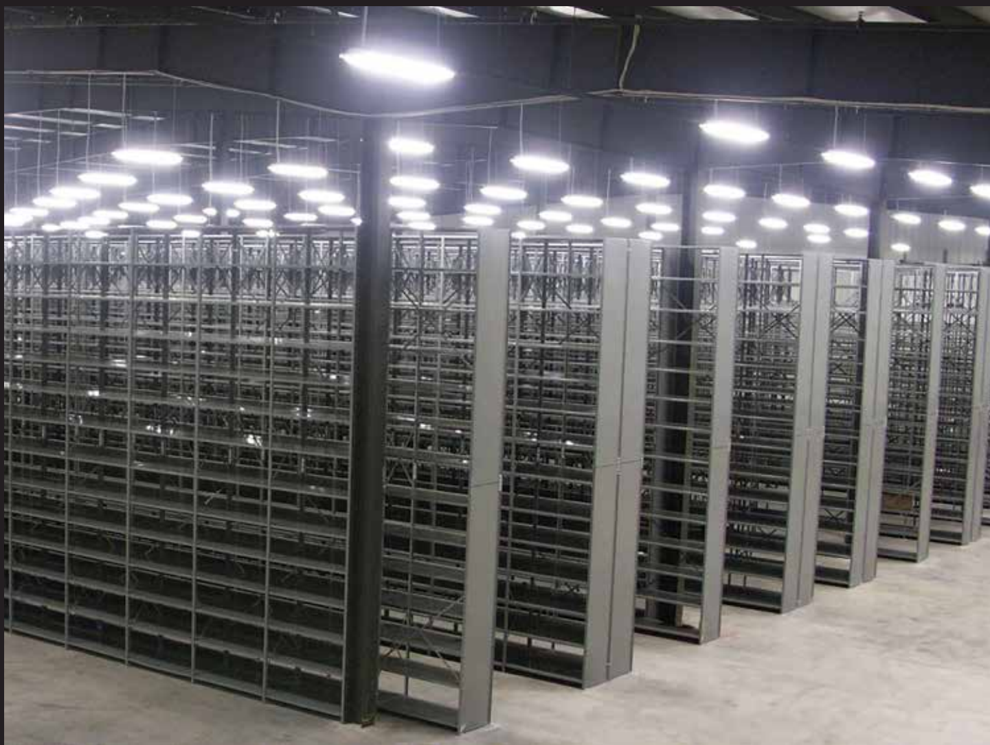
/ Système d'étagères grande élévation pour une entreprise du secteur des produits électroniques
